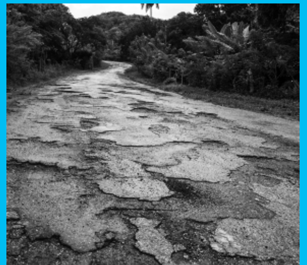
La carretera de Güinía de Miranda a Río Seibabo está totalmente llena de baches. Esta vía es muy utilizada en viajes de turismo, pues es el camino más directo hacia Trinidad desde Villa Clara.
