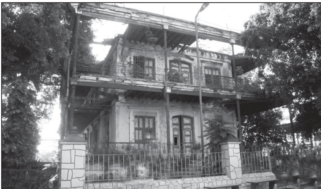
Vista frontal de la casa-vivienda de la familia Cacicedo y Torriente. Está en áreas del ingenio Ifraín Alfonso, en Ranchuelo. Una reliquia ecléctica de la arquitectura doméstica. (Foto: Ramón Barreras Valdés).
