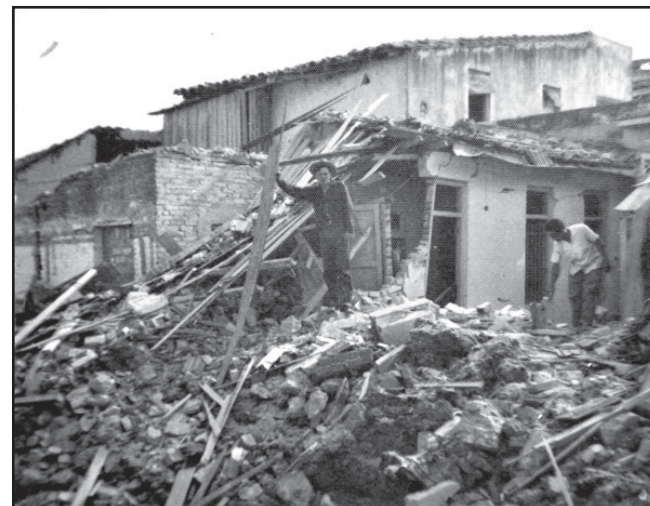
Así quedó una de las casas de Santa Clara por los bombardeos de la dictadura.
