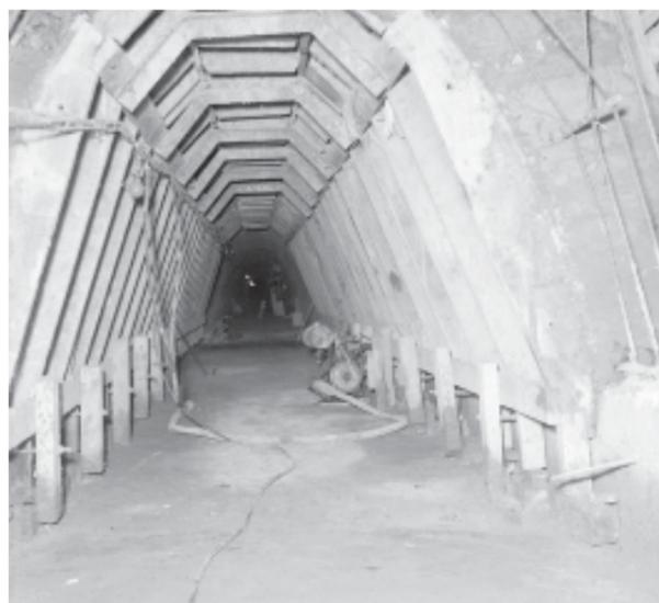
**En la trayectoria de las tuberías hacia Santa Clara se construyeron tres túneles como este, que atraviesan el lomerío de Agabama: El Chico, de 138,5 m; Rebacadero (250 m), y Piedra de Amolar (523,75 m).**
