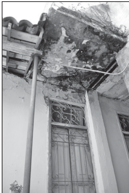
Así están los techos en la escuela especial Sueños Martianos, razón por la que se redistribuirán sus alumnos para comenzar los trabajos constructivos.
