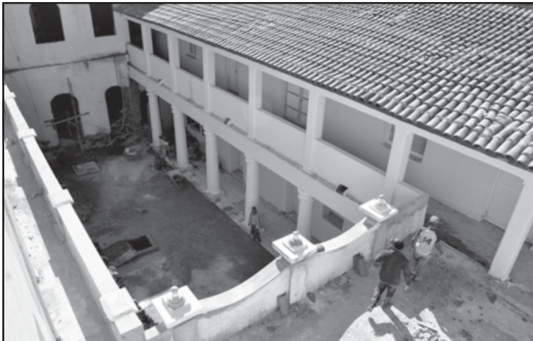
Alrededor de 40 obreros trabajan en la escuela Juan Oscar Alvarado. La parte más dañada del inmueble estaba ubicada en el edificio de dos plantas que da a la calle Cuba. Por el alto nivel de deterioro hubo que demolerlo y empezar desde los cimientos.
